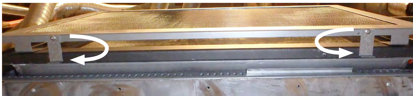
Figure 13.4.04: Faites tourner les loquets de montage sous le cadre de la vitre pour fixer le pare-étincelles en place.
